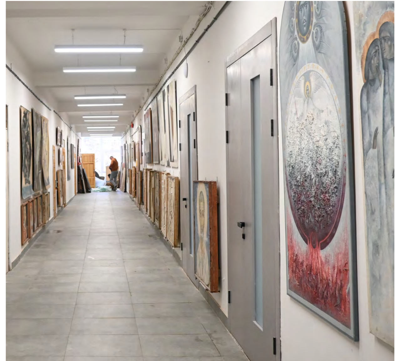
Ремонт коридору на другому поверсі корпусу №4
