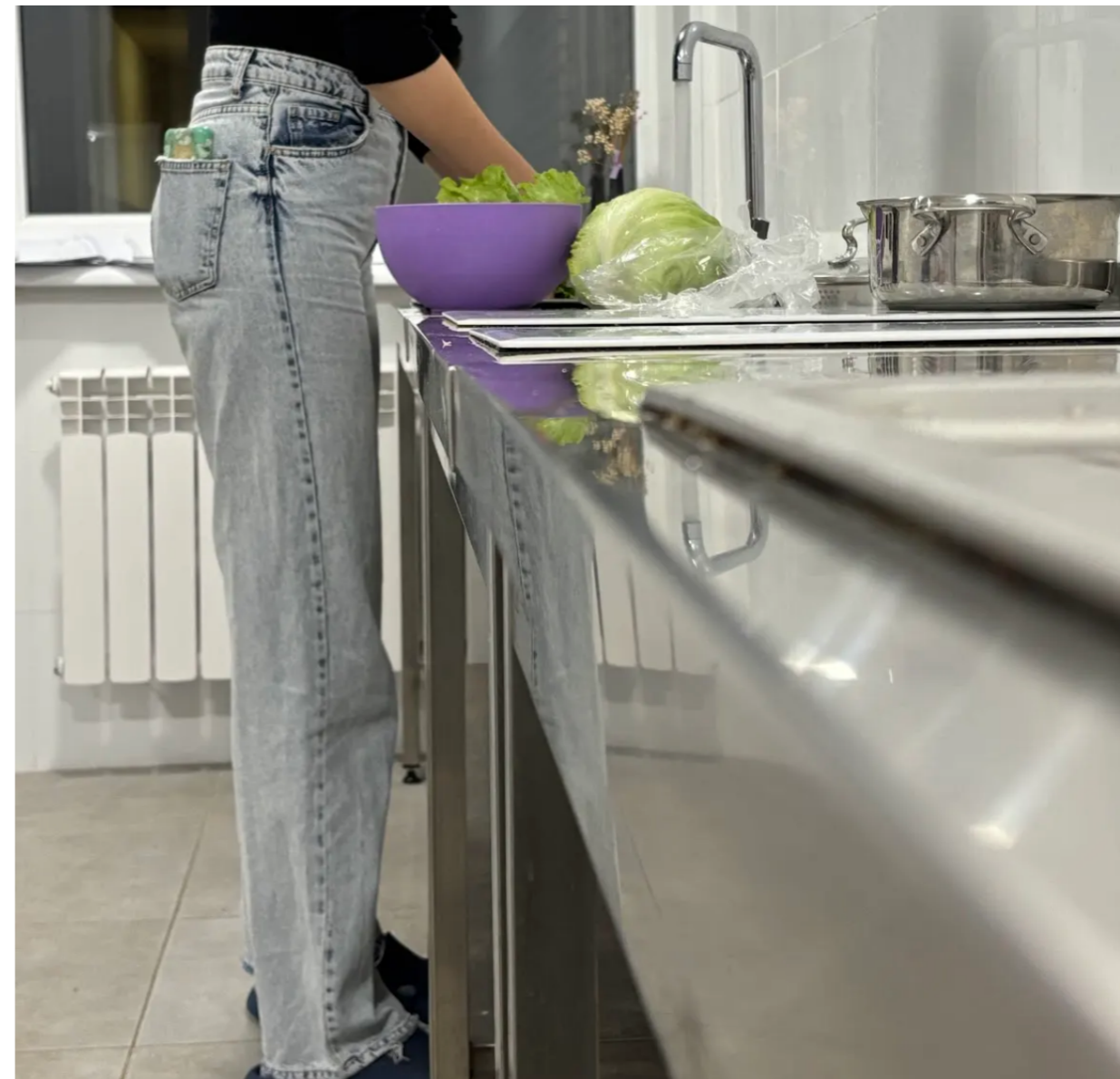
Обладнання кухні в гуртожитку індукційними плитами, мийками та робочими столами з нержавіючої сталі
