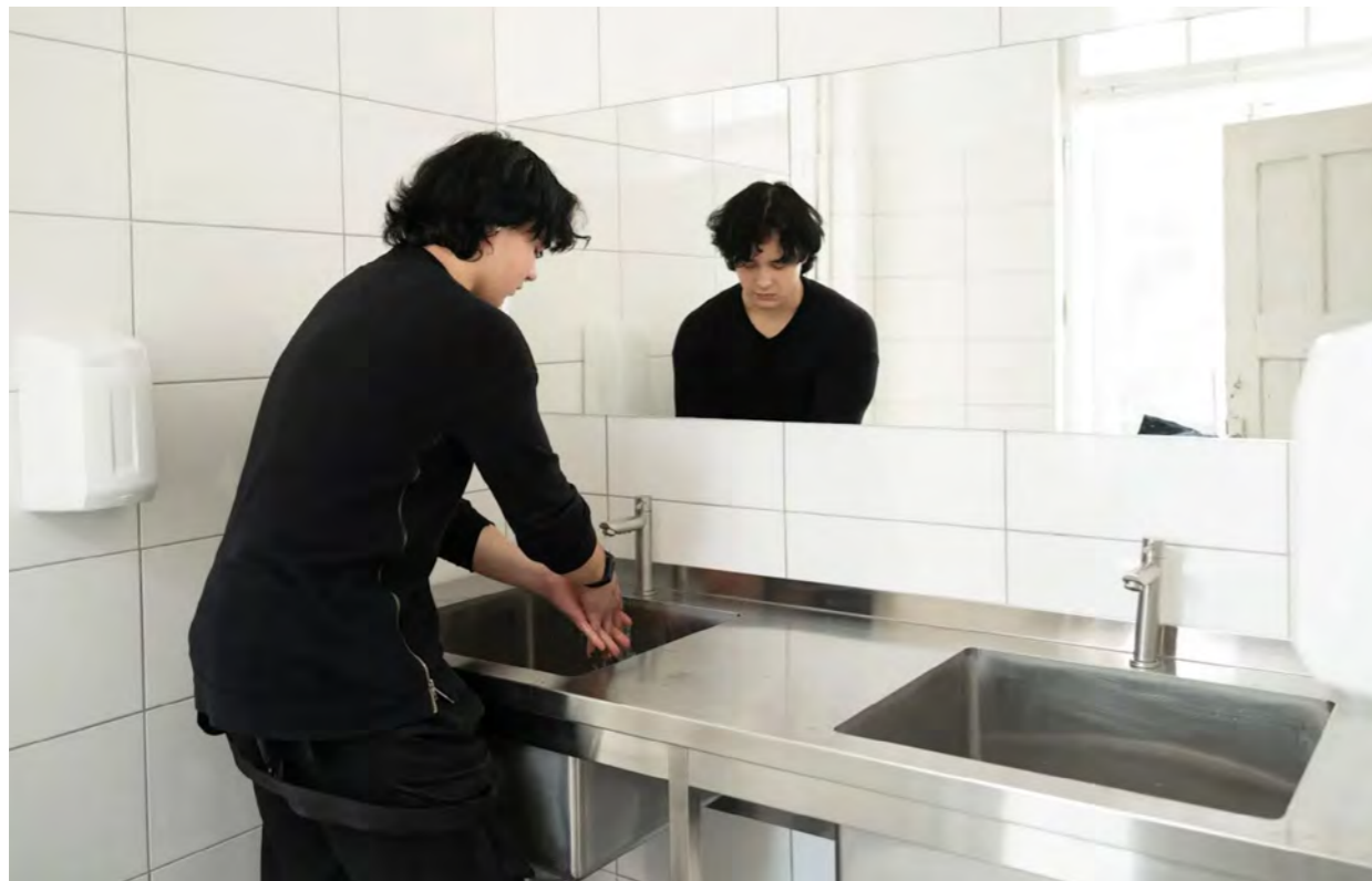
Ремонт із переглянуванням санвузлів у корпусі № 5
